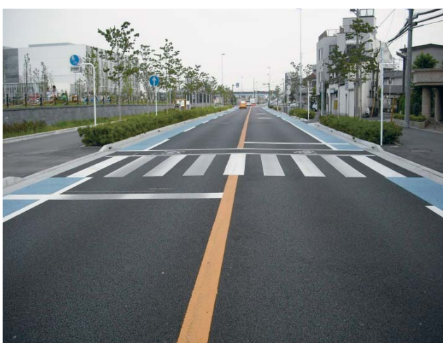
<自転車専用通行帯の整備事例(幸区)>
