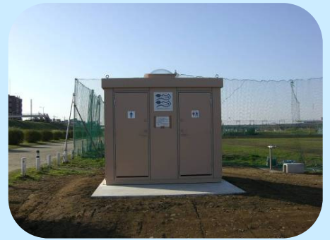
簡易水洗トイレ
