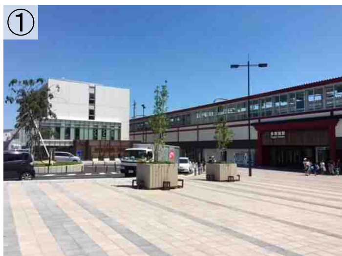
① 多賀城駅と駅前広場(北口)
