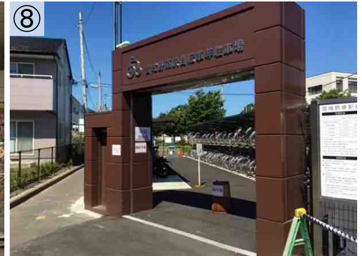
⑧ 地表面に整備された駐輪場
