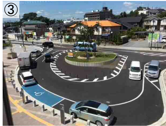
③ 多賀城駅 駅前広場(北口)
