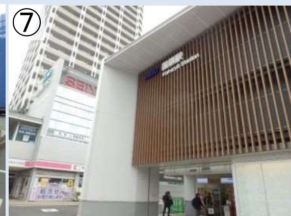
⑦ 国領駅（地上駅舎） 改札口やコンコースは地表面に整備
