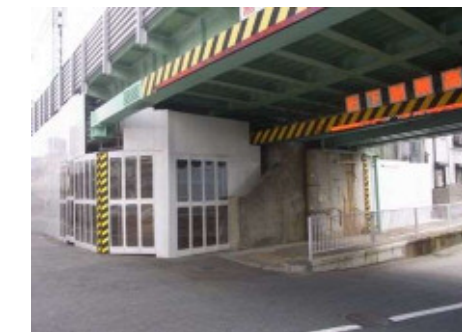
工事進捗状況の見える化
