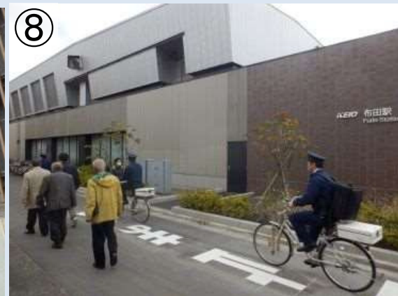
⑧ 布田駅（地上駅舎） 改札口やコンコースは地表面に整備
