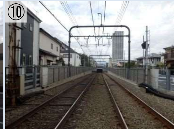
⑩ トンネルへの出入口部分
