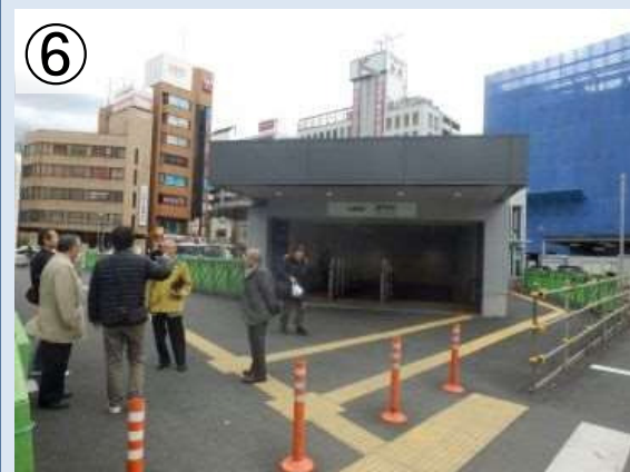
⑥ 調布駅の入口（地表面） 改札口やコンコースは地下1階に整備
