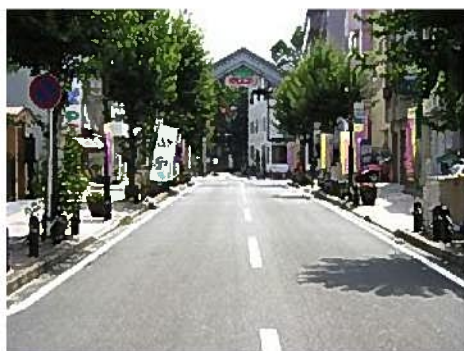
整備前の道路
