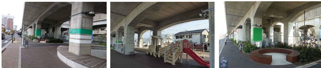
事例：JR 中央線 武蔵境駅一東小金井駅間高架下
