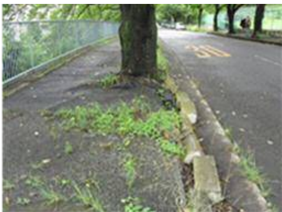
舗装を持ち上げる根上がりの発生
