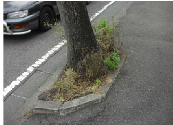
狭小な植栽枿のため根上がりが発生
