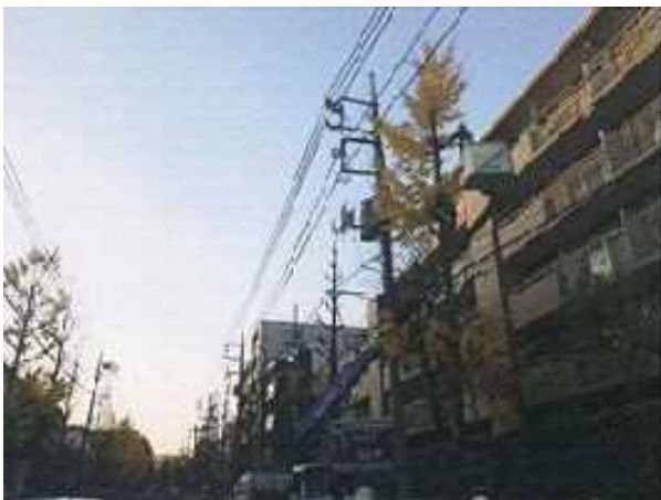
高所作業車による剪定状況
