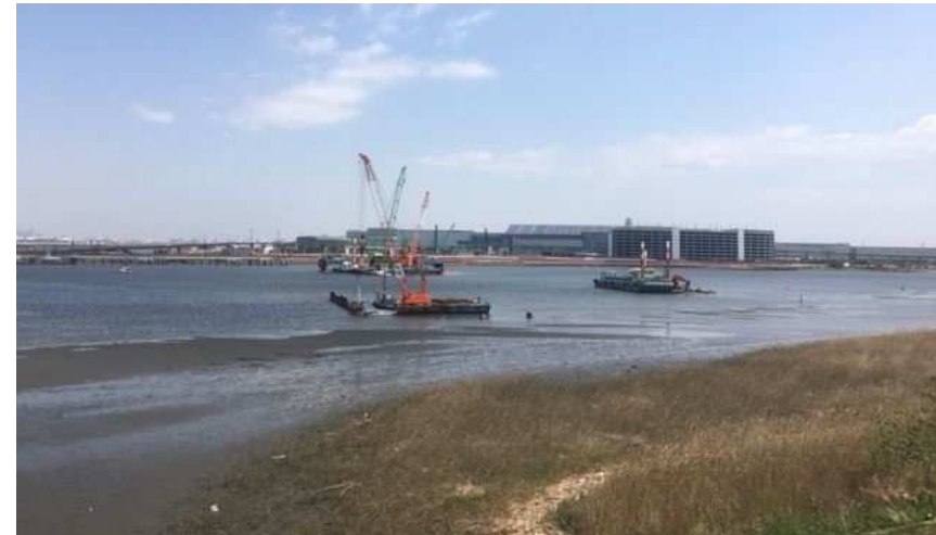
工事状況(2018年4月撮影 殿町側から羽田空港側を望む)
