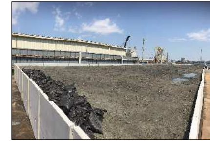
仮置き場全景
