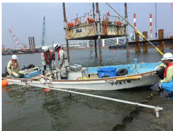
図3 計測計設置状況
