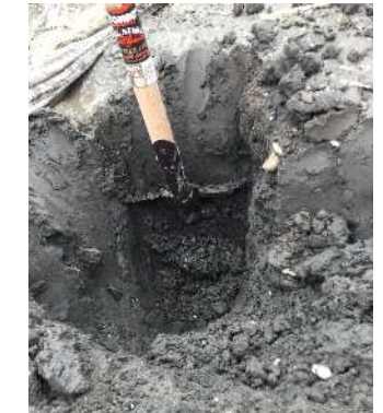
掘削（0.5m）状況
