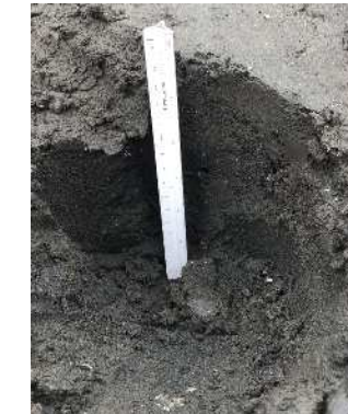
掘削（0.15m）状況
