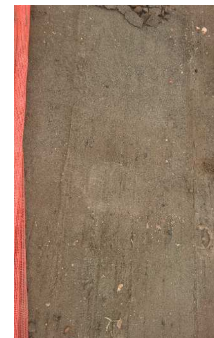
養生シート下の状態12月
