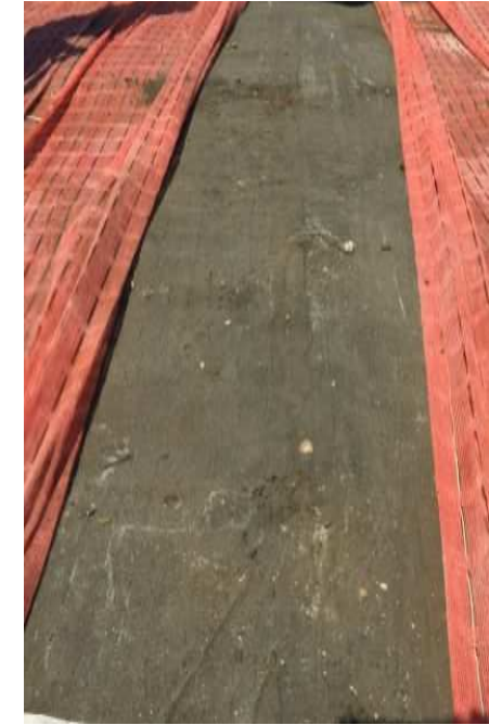
養生シート下の状態（4月）
