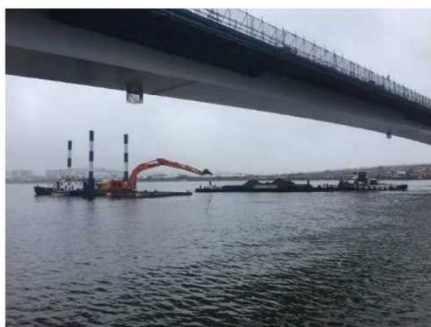
埋戻し投入状況
