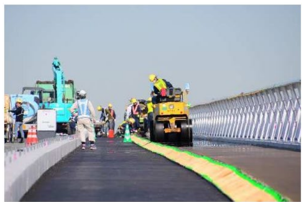
歩道舗装状況
