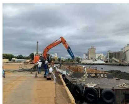
仮置き土砂積込状況
