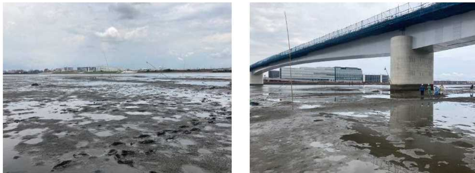
図 2.20 埋戻し完了全景
