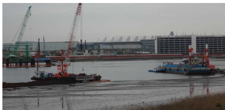
図 2.13 築造部浚渫状況
