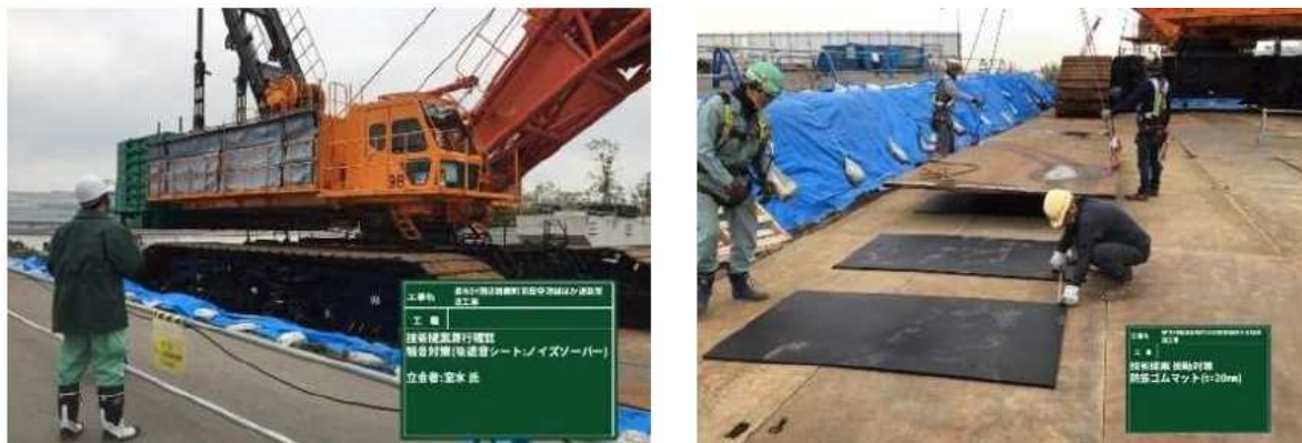
図 2.32 遮音シート（左）及び防振ゴムマット（右）の設置状況
