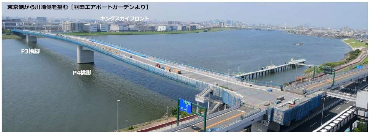
橋梁部地覆コンクリート実施状況
