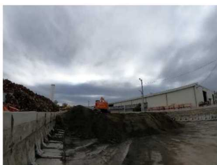
仮置き土砂搬出状況
