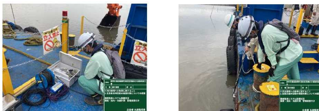
図 2.27 水質調査状況（埋め戻し時）
