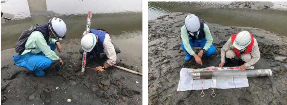
図 2.21 表土埋め戻しの確認状況
