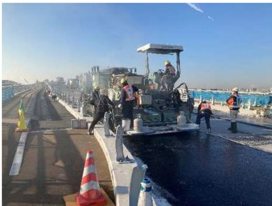
車道舗装状況
