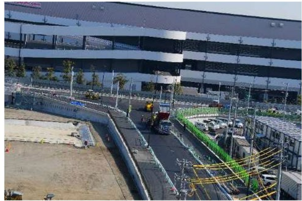
交差点部道路舗装状況
