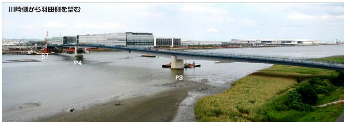
ベント設備 (B7) 撤去状況
