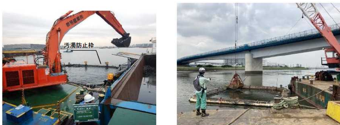
図 2.26 汚濁防止枠の設置状況（左：浚渫時、右：埋め戻し時）
