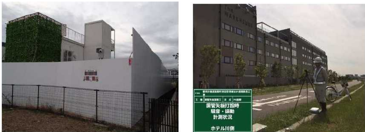
騒音振動計設置状況
