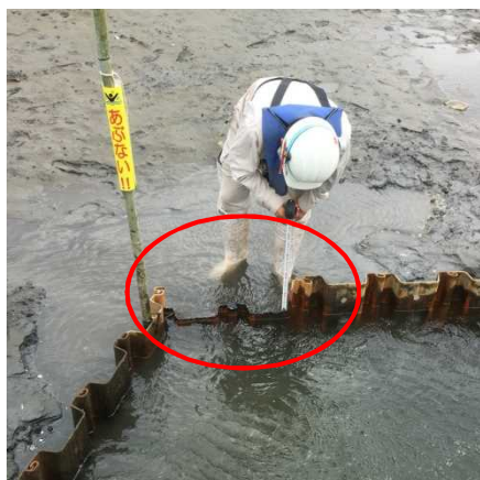
図 2.15 矢板打ち下げ状況 (帯水対策) (左) 及び緩衝帯地形変化確認状況 (右)
