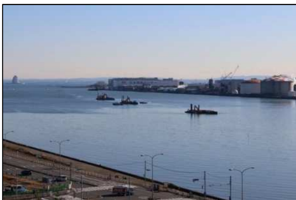
航路部の浚渫状況
