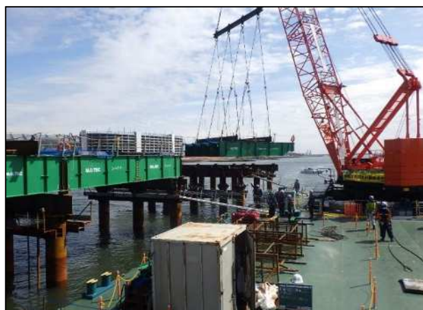
作業構台設置状況
