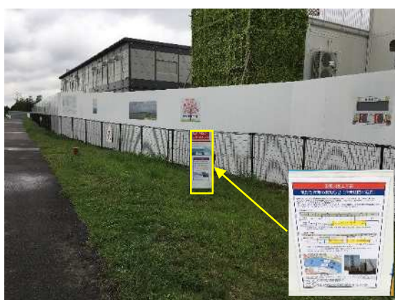
図 2.2.26 工事内容看板設置状況 (多摩川サイクリングロード沿い)
