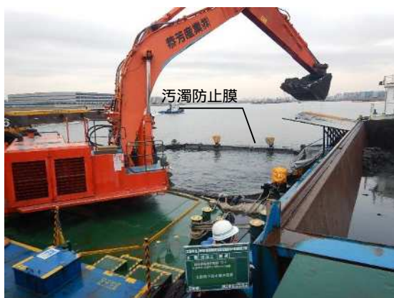
図 2.2.21 汚濁防止膜設置状況 (しゅんせつ時)
