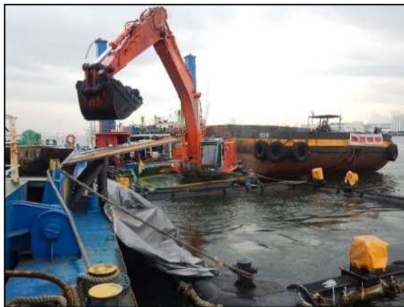
浚渫状況（近景）
