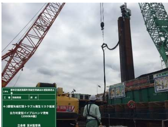
図 2.2.22 稼働状況確認
