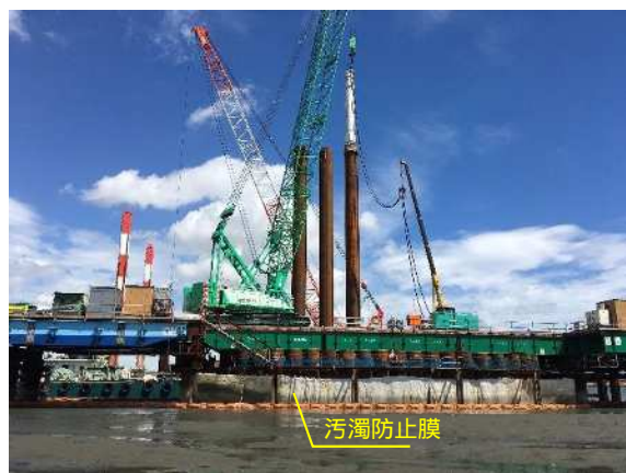
図 2.2.20 汚濁防止膜設置状況 (鋼管矢板打設時)
