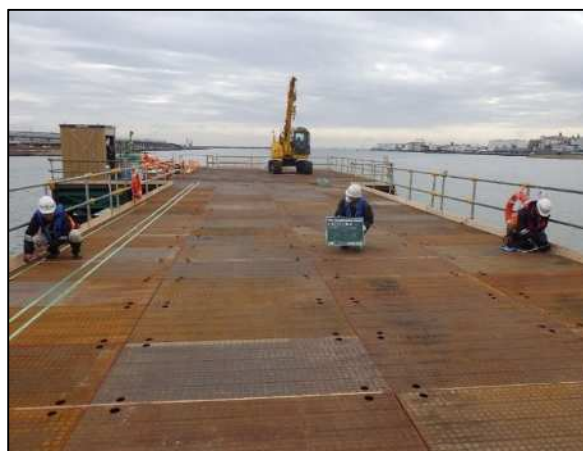
作業構台 組立完了全景
