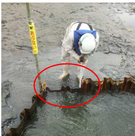
図 2.2.16 矢板打ち下げ状況(帯水対策)
