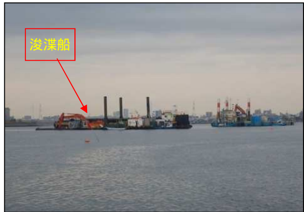
築造部の浚渫状況
