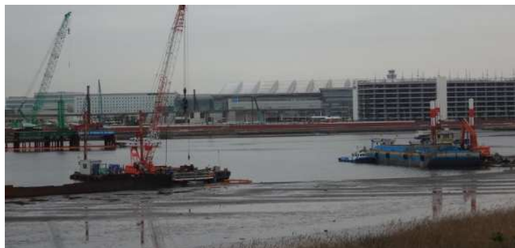
図 2.2.14 築造部浚渫状況
