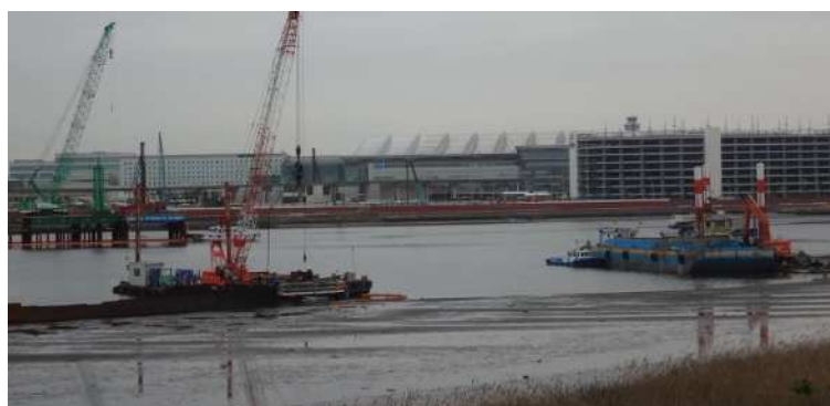
図 2.2.14 築造部浚渫状況
