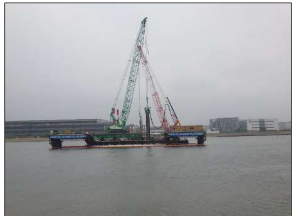
鋼管矢板打設状況全景
