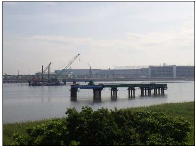
作業構台 組立完了全景 (H30.6.15)
