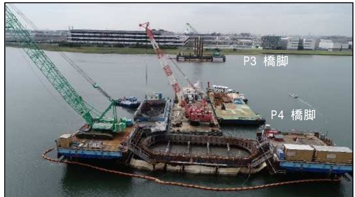
鋼管井筒内掘削状況 (P4 橋脚)
