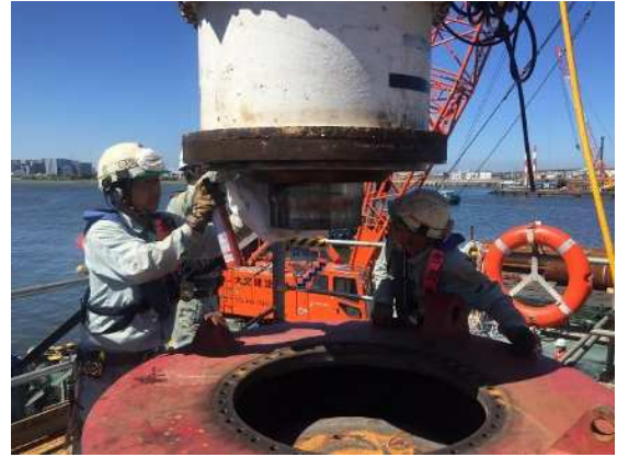
図 2.2.29 始業前点検状況 (鋼管矢板打設用油圧ハンマ)
