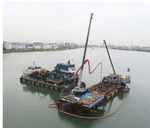
躯体コンクリート打設状況全景
