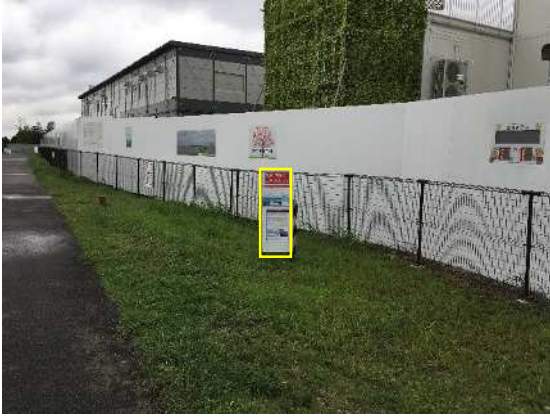
図 2.2.28 工事内容看板設置状況 (多摩川サイクリングロード沿い)
