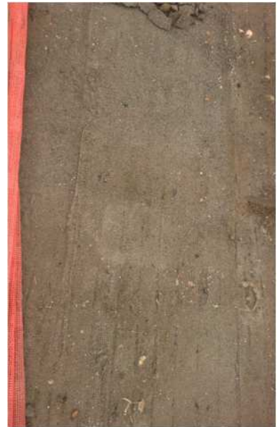
養生シートの下の状態12月
