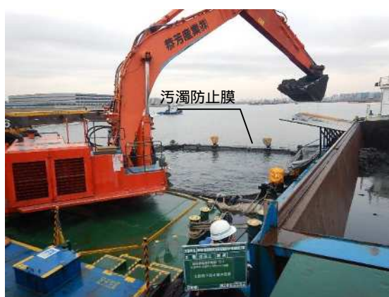
図 2.2.20 汚濁防止膜設置状況 (しゅんせつ時)
