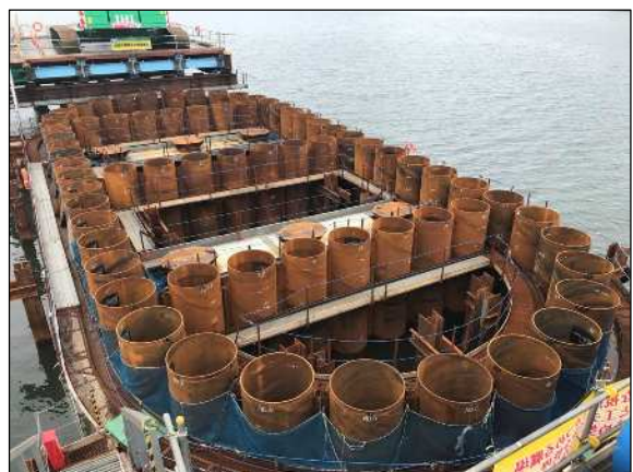
鋼管矢板打設完了 (P4 橋脚)
