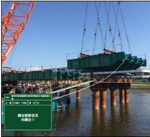
作業構台設置状況 (H30.6.5)
