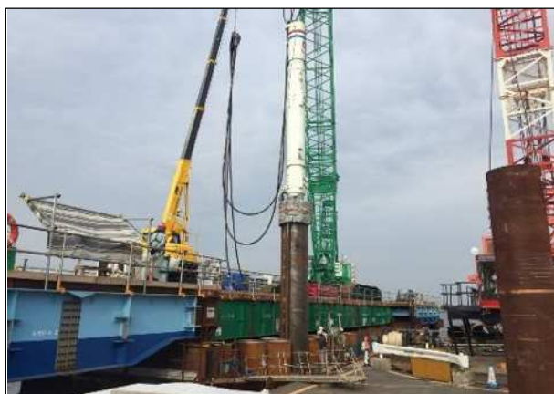
鋼管矢板打設状況 (P4 橋脚)
