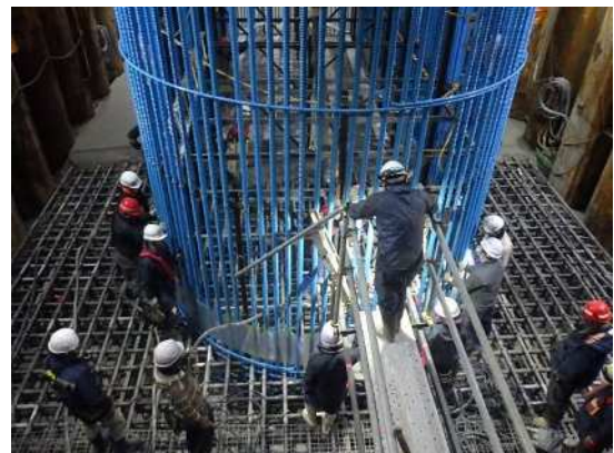
躯体コンクリート打設状況
