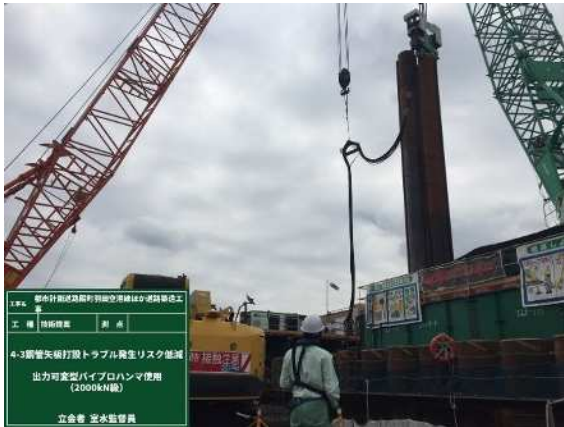
図 2.2.24 稼働状況確認
