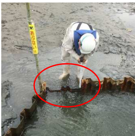
図 2.2.16 矢板打ち下げ状況(帯水対策)
