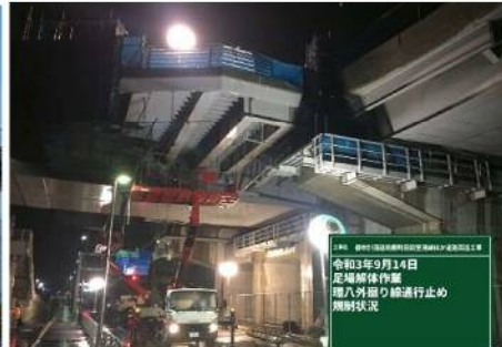
夜間足場撤去状況
