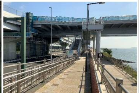
足場撤去完了 (多摩川上流より)
