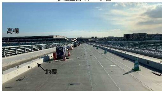
車道部（都県境から殿町側を望む）
