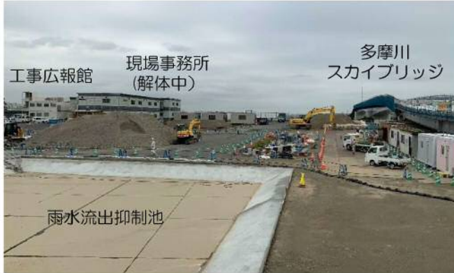
工事ヤード復旧工事状況
