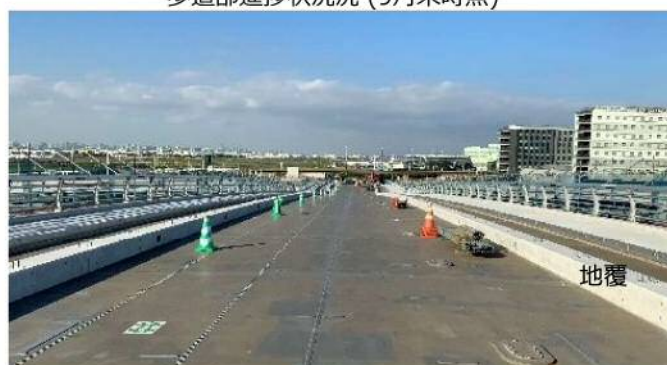
車道部（都県境から羽田空港側を望む）
