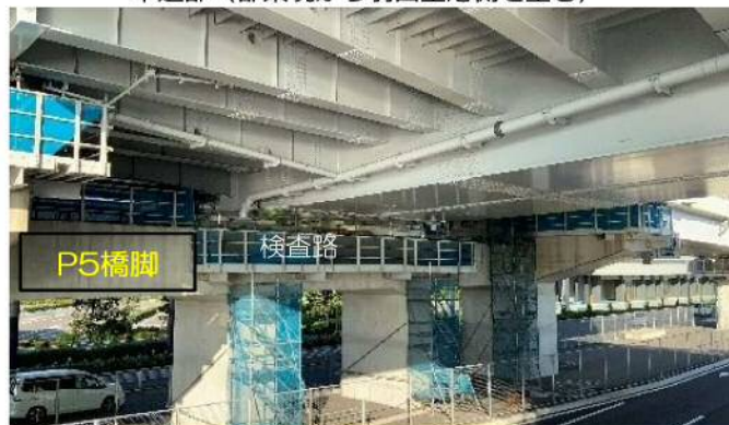
環状八号線橋脚の検査路設置状況
