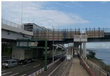
足場撤去前 (多摩川上流より)
