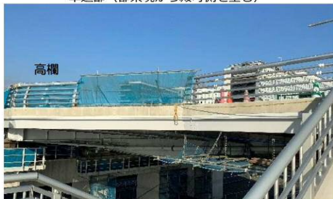
階段から見る高欄設置状況
