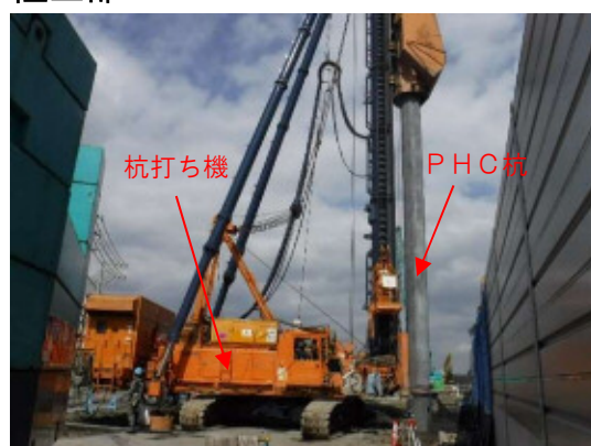
杭打ち機による打設状況
