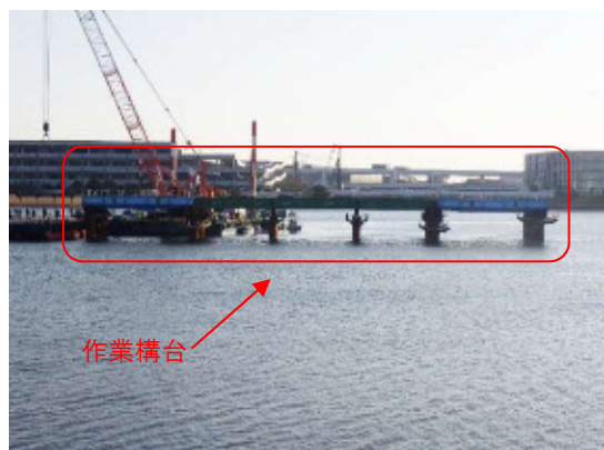
クレーン付台船による作業構台設置状況
