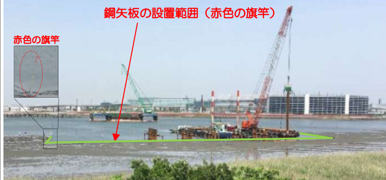
干潟部での作業状況(P3作業構台設置状況)
