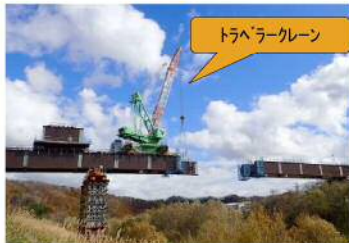
トラバークレーン架設工法
