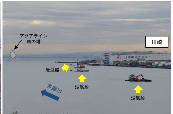
航路部浚渫状況
