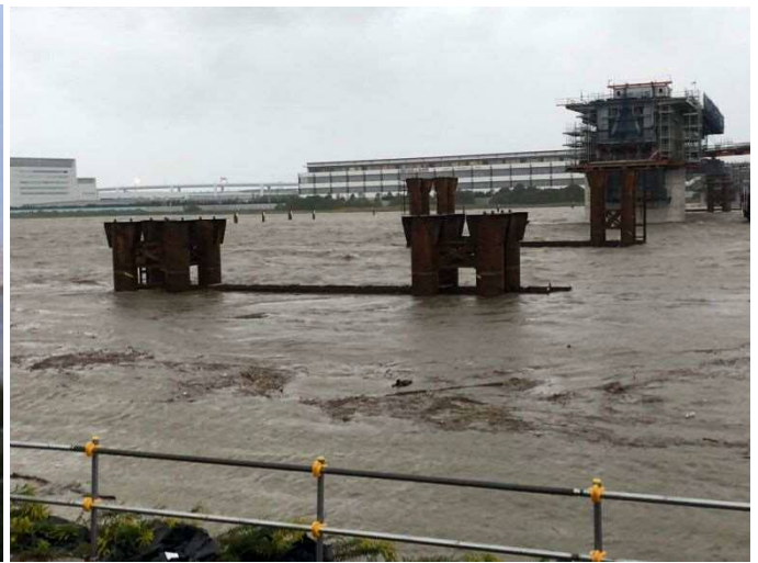
台風通過直後状況 (2019.10.13早朝 羽田空港側より撮影)
