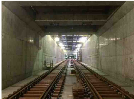
地下トンネル
