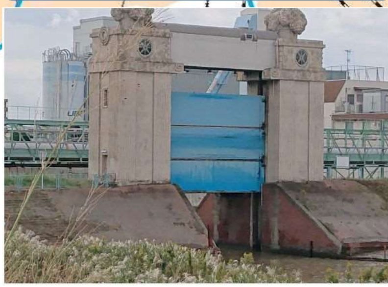
多摩川下流側から河港水門を望む
