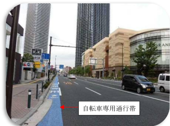
図 4-4 幹線道路の整備に合わせた自転車通行環境の整備（主要地方道東京丸子横浜）
