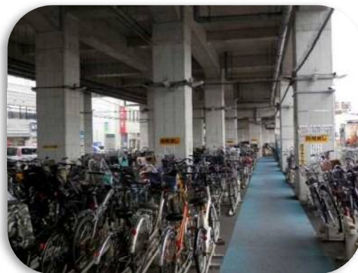
図 4-18 鉄道高架下駐輪場（小田急電鉄 登戸駅）
