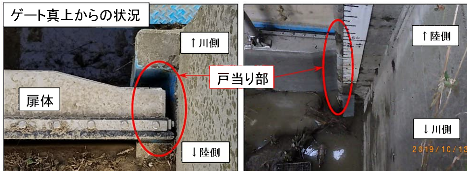
写真: 扉体及び戸当り部
