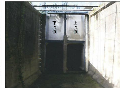
写真: 10月10日点検状況
