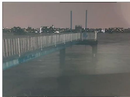
写真: 排水樋管周辺状況(当時)
