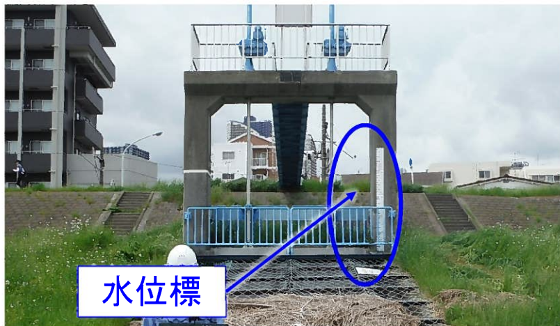
排水樋管部水位標
