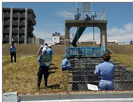
写真: 河川管理者による検査状況
