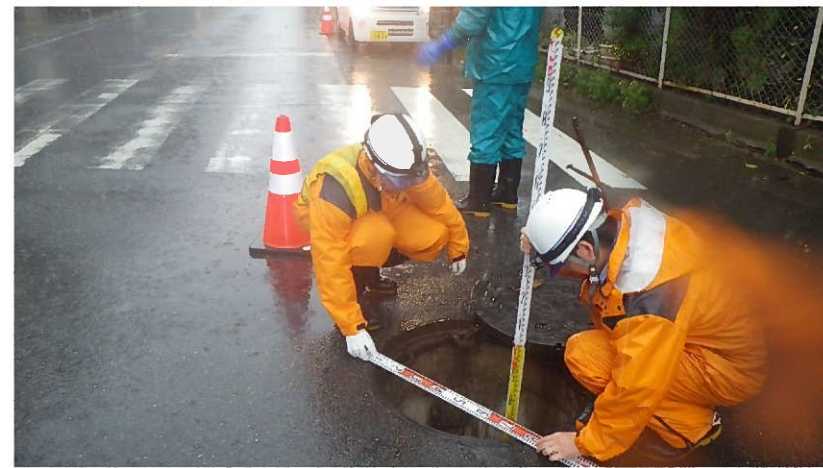
マンホール部 水位計測
