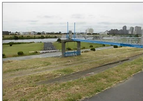
写真: 排水樋管周辺状況(平常時)
