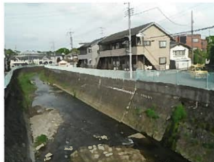
整備後の平瀬川
