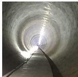
五反田川放水路
