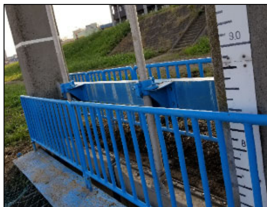
図 12-1-3 排水樋管ゲート室扉体上部の状況
