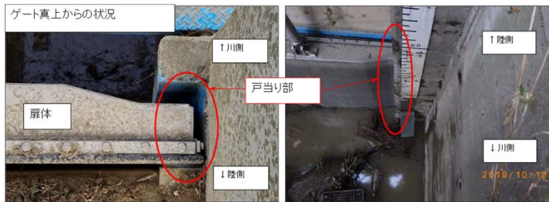
扉体及び戸当り部
