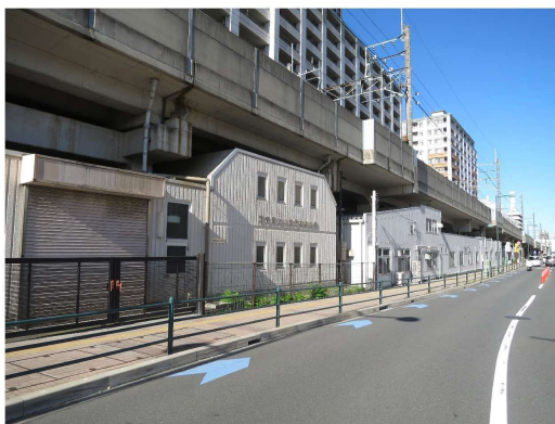
災害用資材庫 (JR南武線 武蔵小杉駅～武蔵新城駅間)
