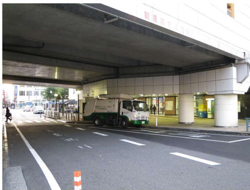
歩道に切れ込みを入れたバス停留所 (小田急江ノ島線 大和駅付近)
