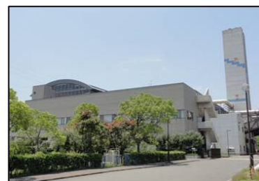
入江崎総合スラッジセンター
