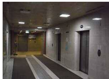
エレベーターホールのLED化（第3庁舎）
