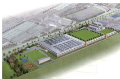
高度処理施設の整備の推進 入江崎水処理センター西系再構築事業
