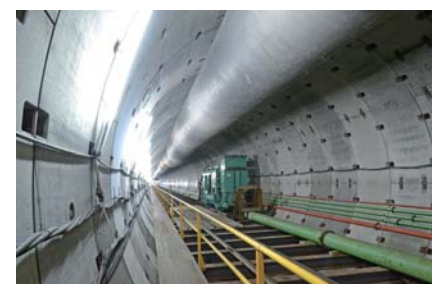
大師河原貯留管の整備
