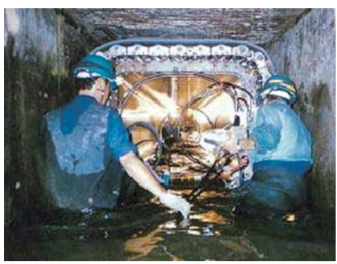
下水道管きよ更生工事
