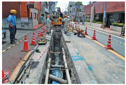
配水管布設替工事
