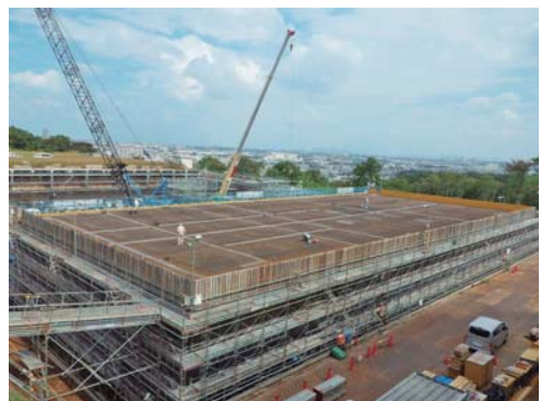
生田配水池更新工事
