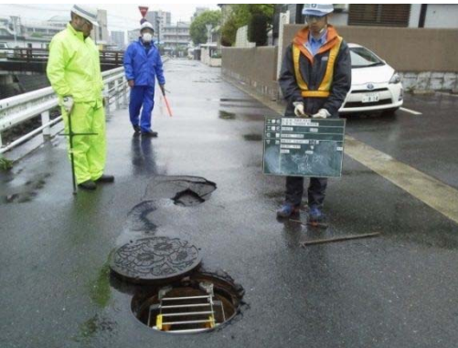
道路陥没箇所の状況確認
