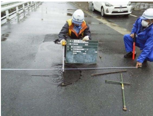
マンホールの変位量の計測①
