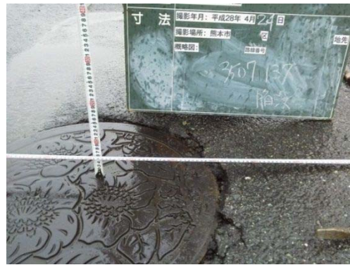
マンホールの変位量の計測②
