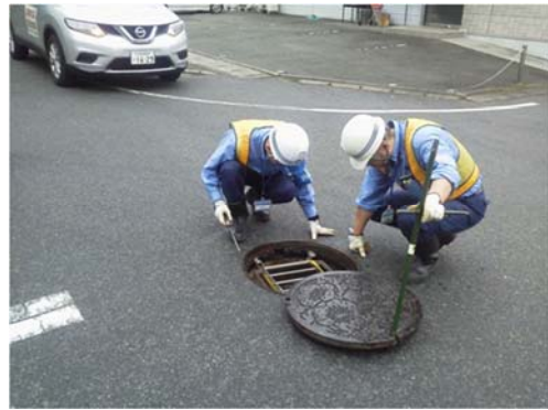
マンホール内状況確認
