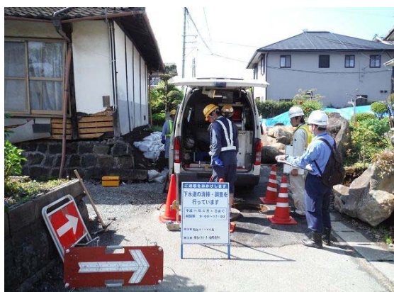
TVカメラによる管きょ内調査
