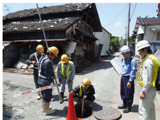
マンホールの調査
