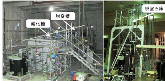
研究開発中の高度処理技術の実験プラント
