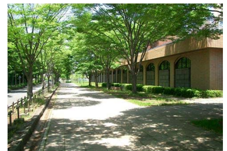
麻生水処理センター
