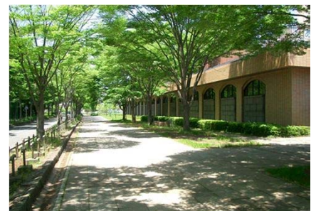
麻生水処理センター
