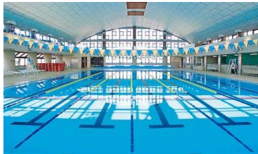
入江崎余熱利用プール
