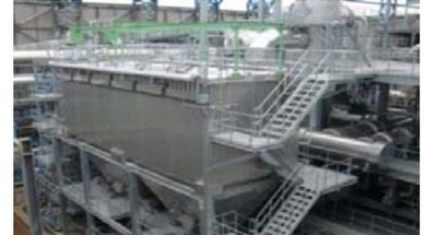
採用したセラミックフィルター式集塵機
