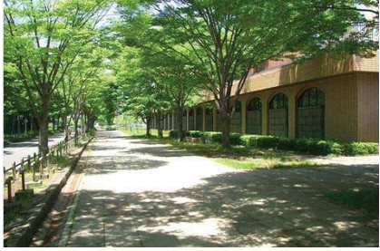
麻生水処理センター
