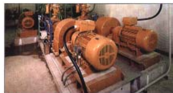
汚泥圧送ポンプ 水処理で発生した汚泥を入江総合スラッジセンターへ送る設備です。
