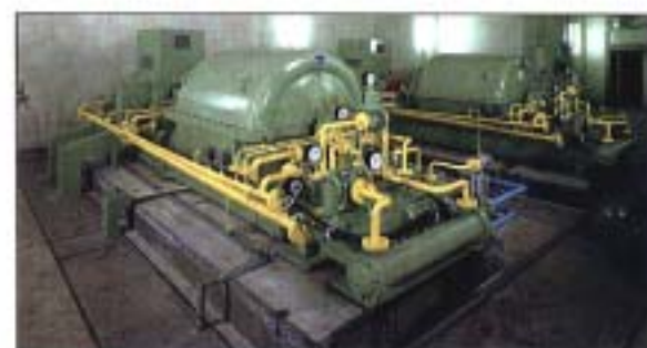
ブロウ 空気を反応タンクに送る設備です。
