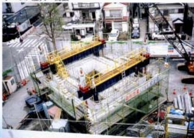
ケーソン圧入・沈設
