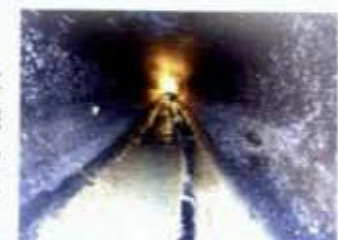
▲下水道暗きょ内への光ファイバーケーブル引流しの状況
