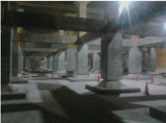
配水池の耐震補強状況
