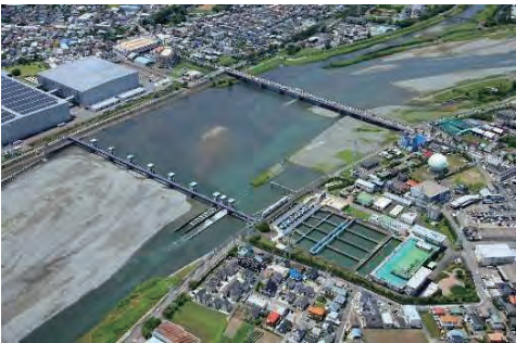
酒匂川から取水する飯泉取水堰
