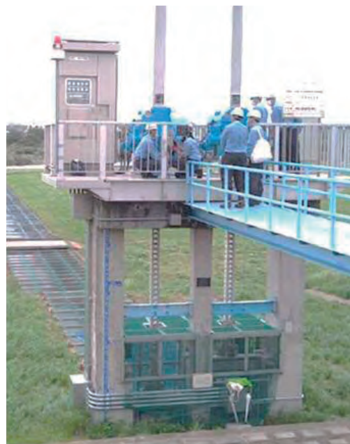
排水樋管ゲート操作訓練
