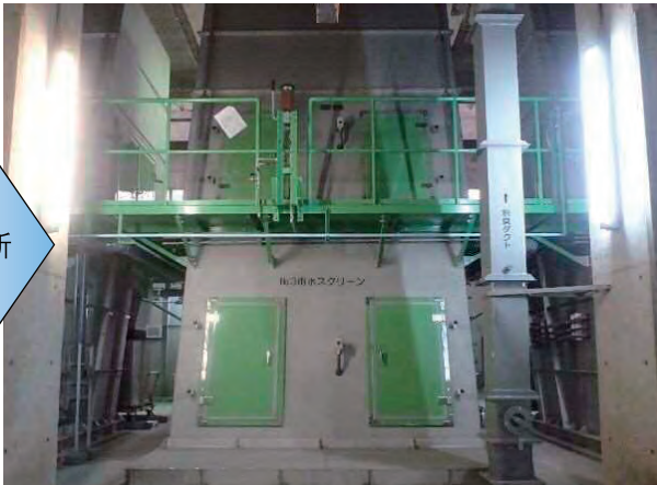
老朽化したスクリーン設備の更新
