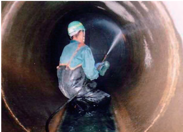
管きよの清掃状況
