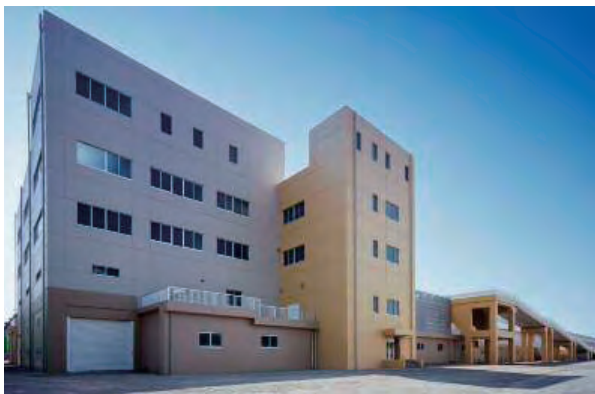
入江崎水処理センター西系施設
