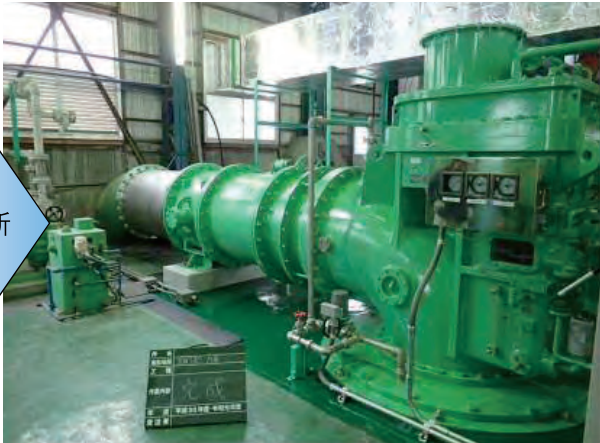
老朽化したポンプ設備の更新
