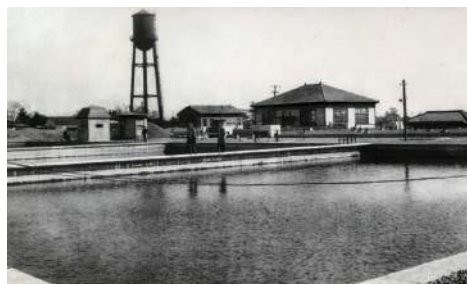
戸手浄水場（大正10年当時）
