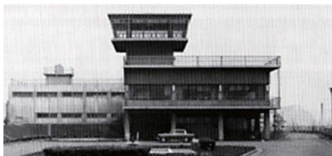
建設当時の入江崎水処理センター
