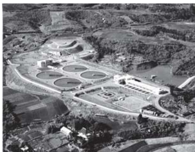
長沢浄水場（昭和29年当時）
