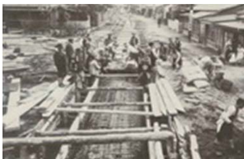
昭和初期の下水管きよの整備
