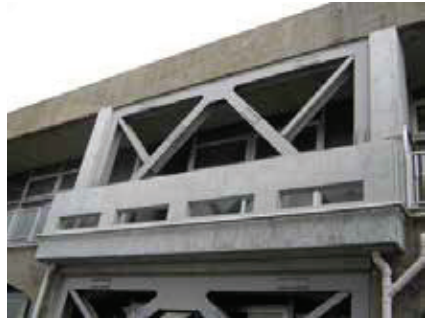
管理棟の耐震化(ブレースの設置)
