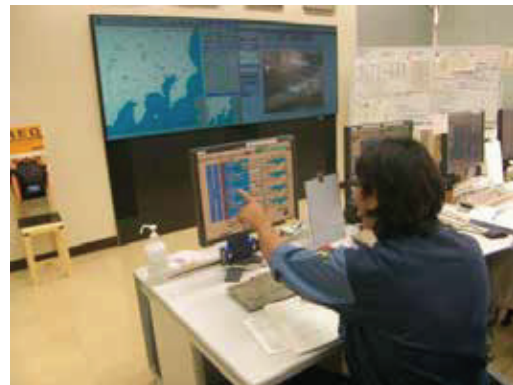
中央監視制御装置による施設の運転
