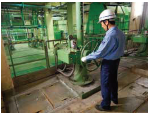
機器点検の実施状況
