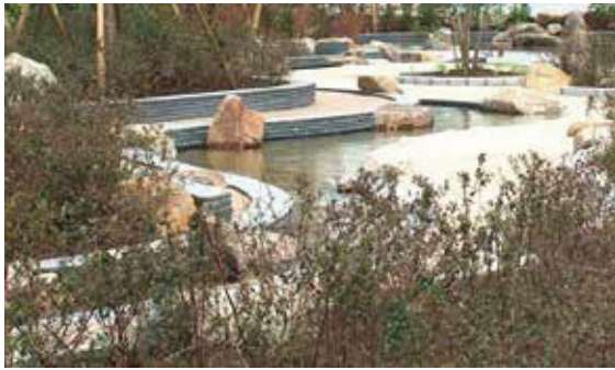
入江崎水処理センターせせらぎ水路
