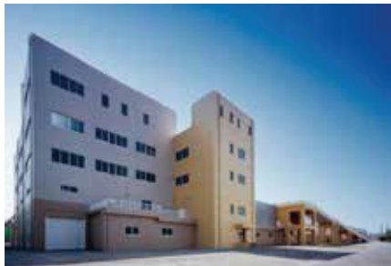
入江崎水処理センター 西系再構築事業
