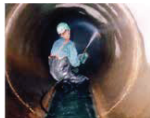
管きよの清掃状況
