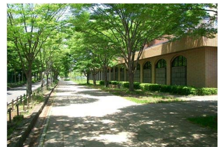
麻生水処理センター
