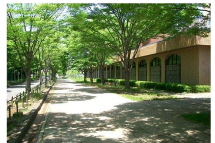
麻生水処理センター
