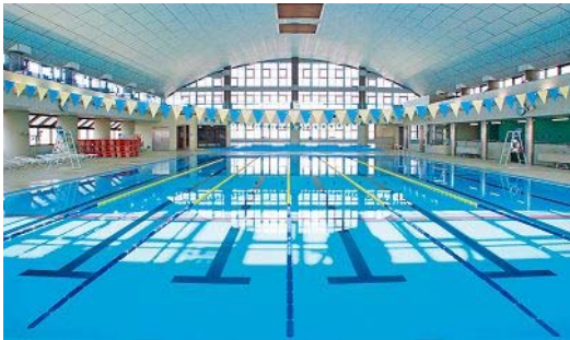
入江崎余熱利用プール
