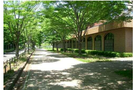
麻生水処理センター
